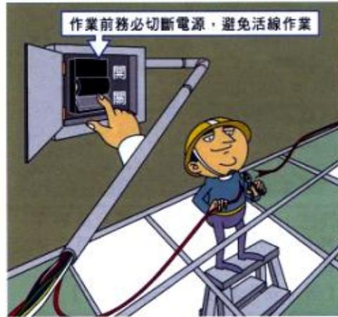
3. 臨時用電設備或線路，應施行接地外，並在電路分路裝設漏電斷路器。連接於移動電線之攜帶型電燈其燈座露出帶電部分應為手指不易碰觸之構造。
